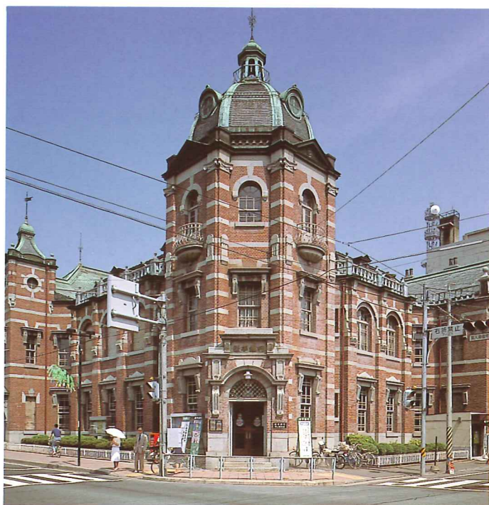
●岩手銀行本店 ●岩手県盛岡市 ●設計/辰野金吾 ●竣工/明治44年
