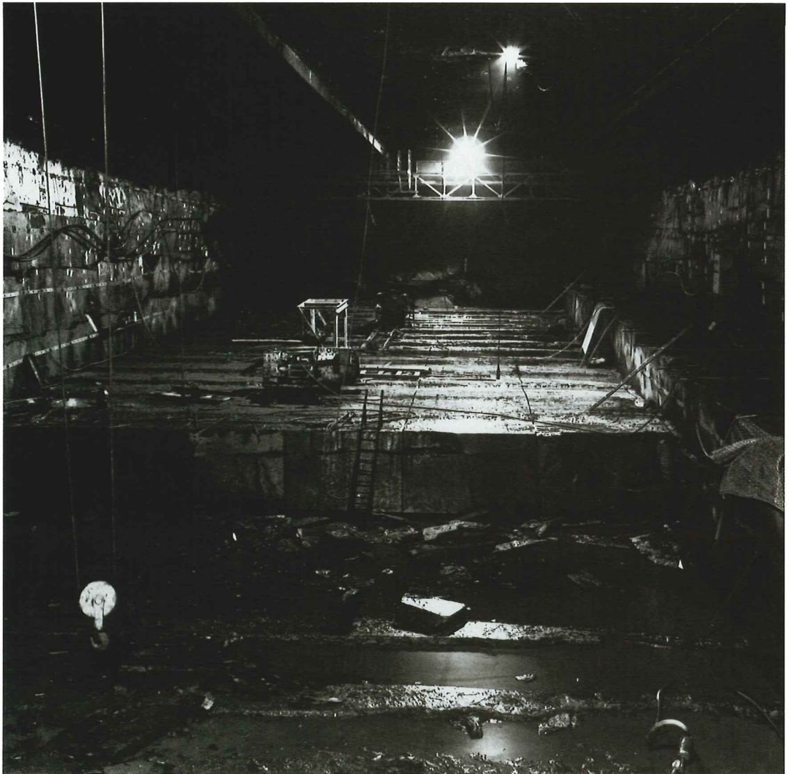
●下進方式によるチャンバ（地下200m）
