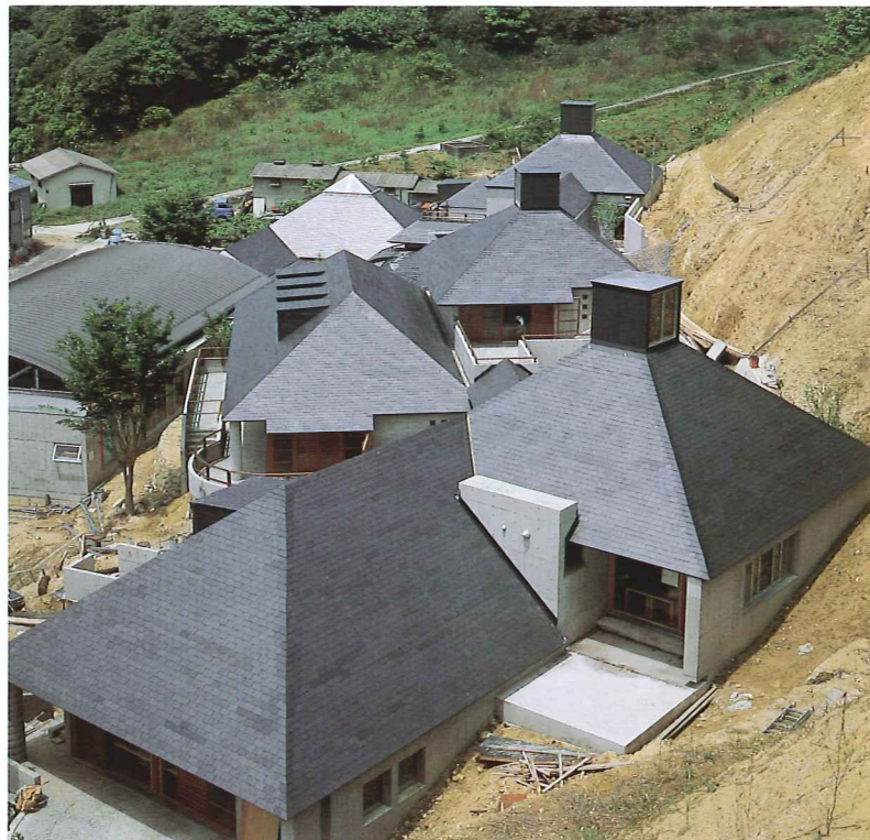
●大護幼稚園●愛媛県松山市●設計/アトリエA&A●施工/共立建設
