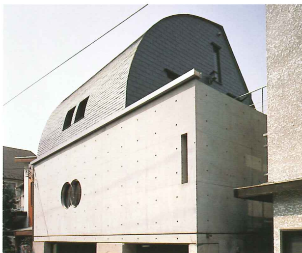
●SHOP,大野邸●東京都世田谷区●設計/千代田建築研究所●施工/穂積
