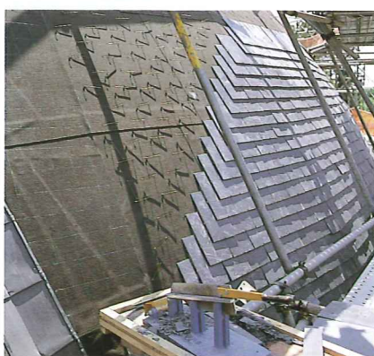
● 天然スレートの取り付け
