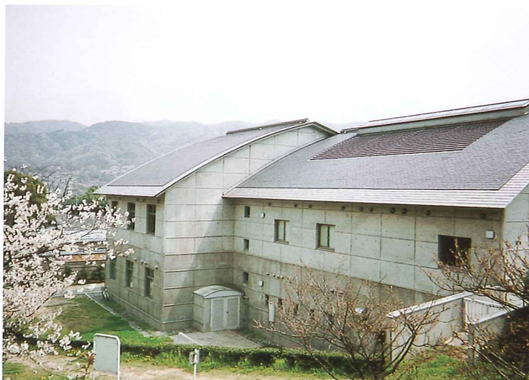
●大阪私立大植物園●大阪府交野市私市●設計/徳岡昌克建築設計●施工/富国建設
