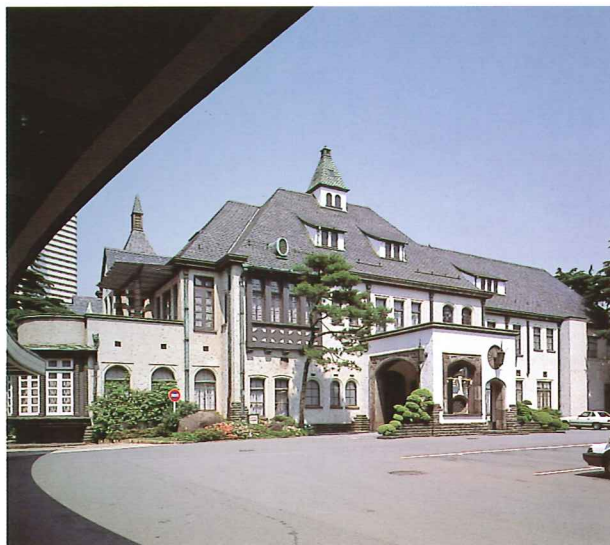
●旧・李王家(現・赤坂プリンスホテル) ●東京都千代田区 ●設計/宮内省内匠寮 ●竣工/昭和3年
