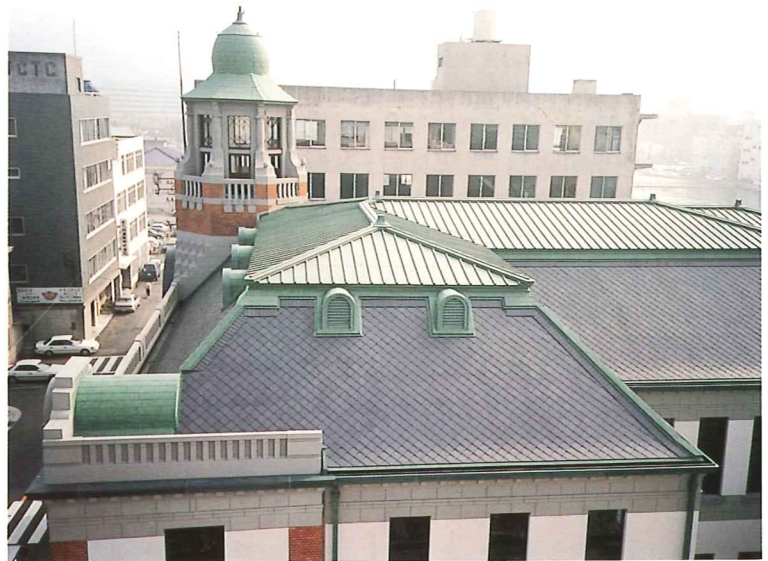
●商船三井ビル(菱葺)●福岡県北九州市●設計/洋建築事務所●施工/熊谷組
