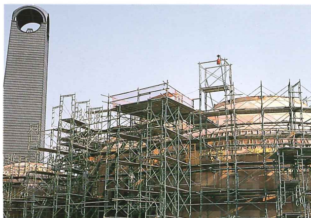
● 屋根下地取り付け
